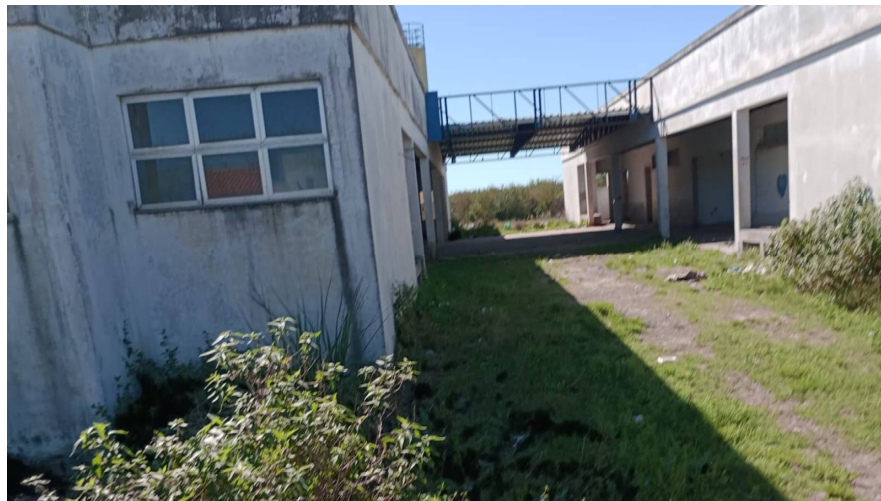
Figura 7 - Vista da cobertura de ligação dos Blocos.
