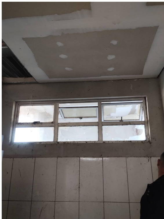
Figura 20 - Fotos Forro de gesso e janela de alumínio.
