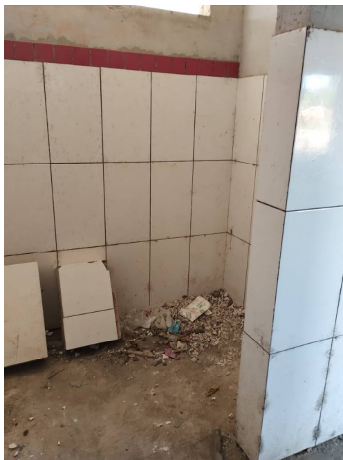
Figura 18 – Foto cerâmica e muretas quebradas.
