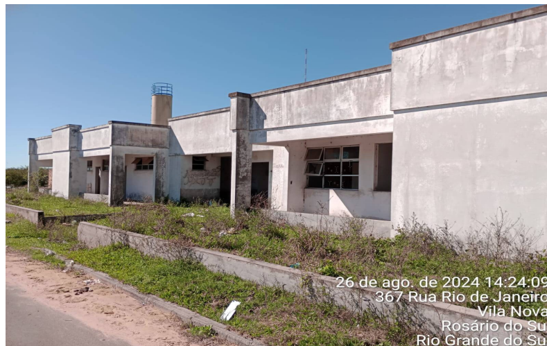
Figura 4 - Vista frontal da edificação. Fonte: elaboração própria
