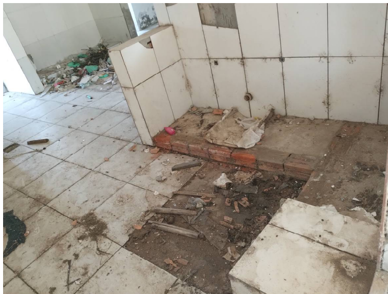
Figura 14 - Foto revestimento cerâmico do piso quebrado.
