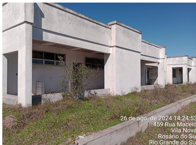
Figura 5 – Vista frontal da construção. Fonte: elaboração própria
