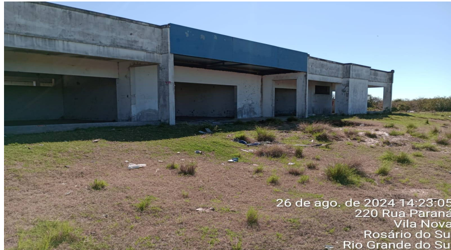
Figura 3 - Vista da edificação aos fundos. Fonte: Elaboração Própria
