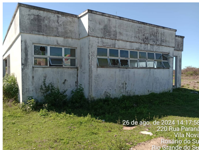
Figura 10 - Vista lateral – Creche 1
