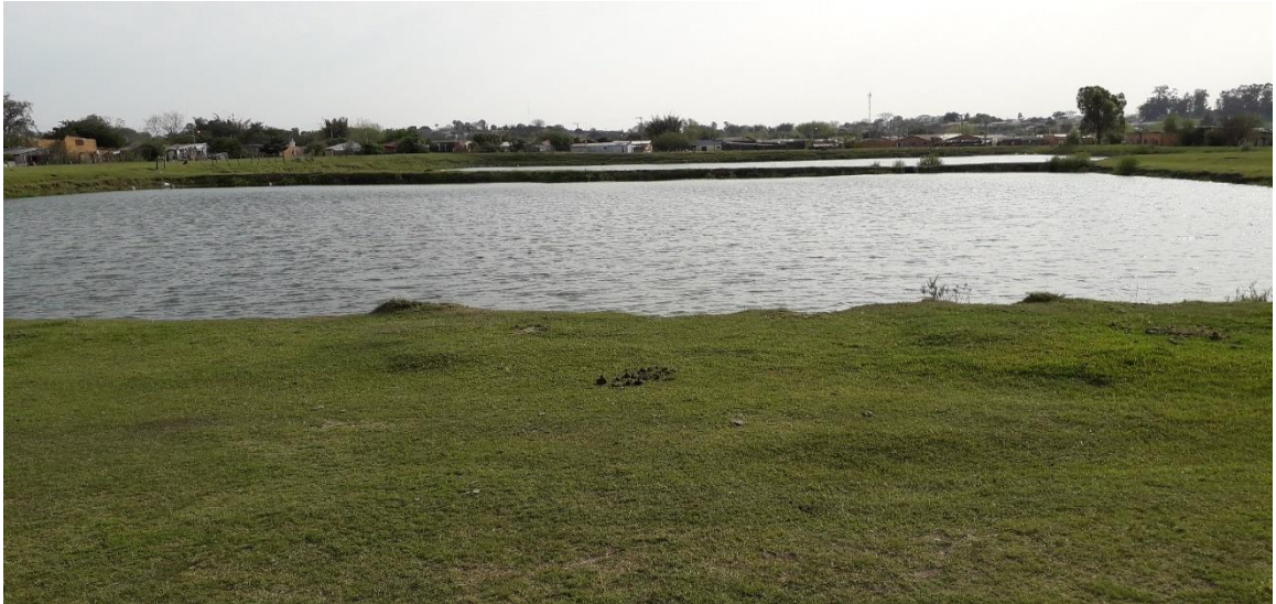
Foto 27: Recebimento de Esgotos - Bairro Ana Luiza
