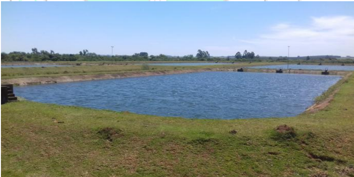
Foto 24: EBE 03 – Recebimento de Esgotos - Bairro Vila Nova
