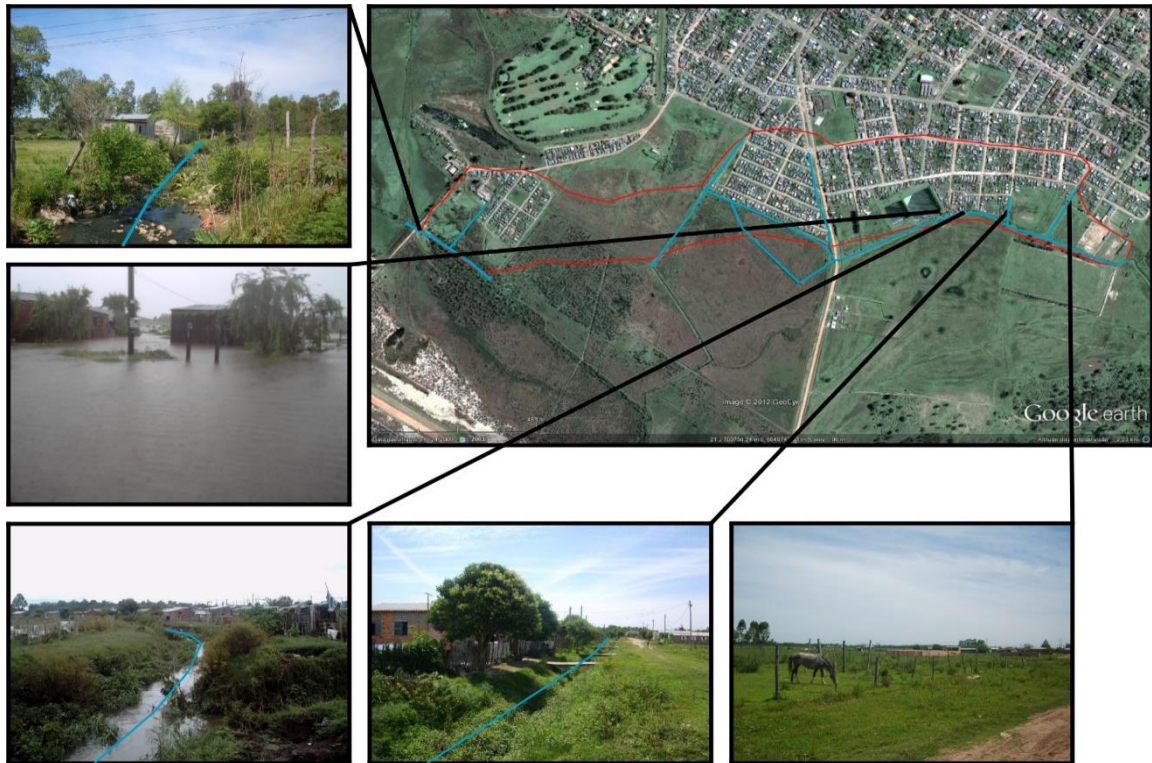
Figura 36. Mostra áreas de alagamento do setor 04 – Fonte CPRM -2012
