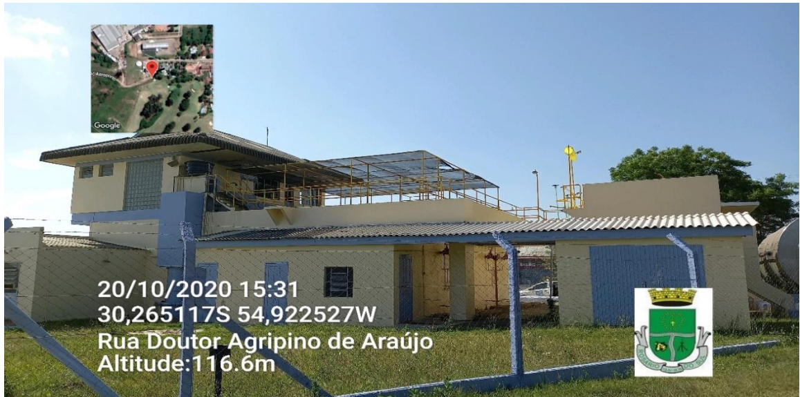
Foto 7: Estação de tratamento de água
