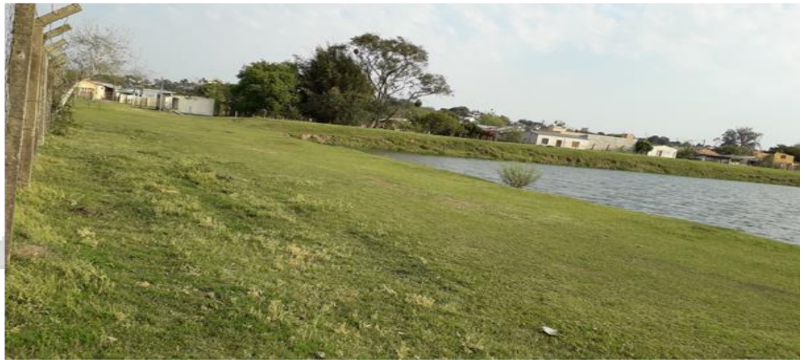
Foto 26: EBE 04 – Recebimento de Esgotos - Bairro Ana Luiza
