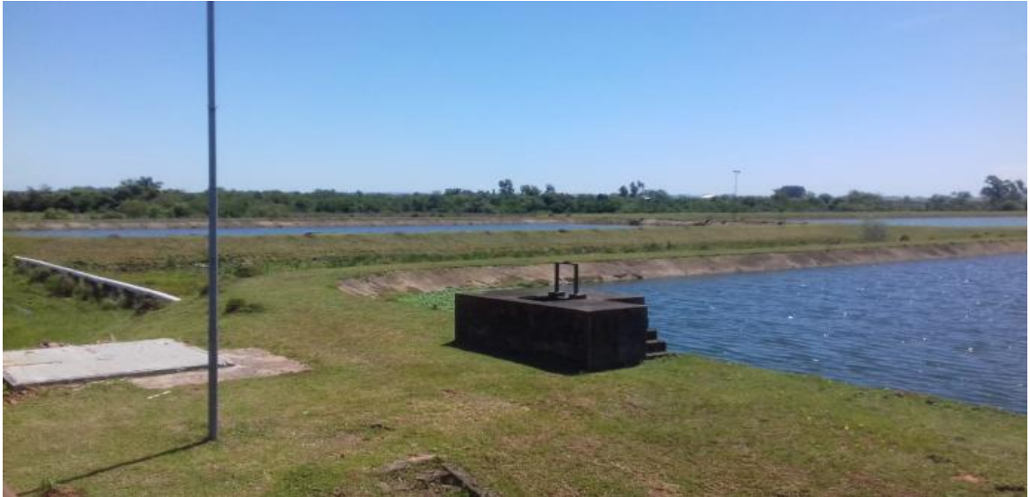
Foto 22: EBE 03 – Recebimento de Esgotos - Bairro Vila Nova
