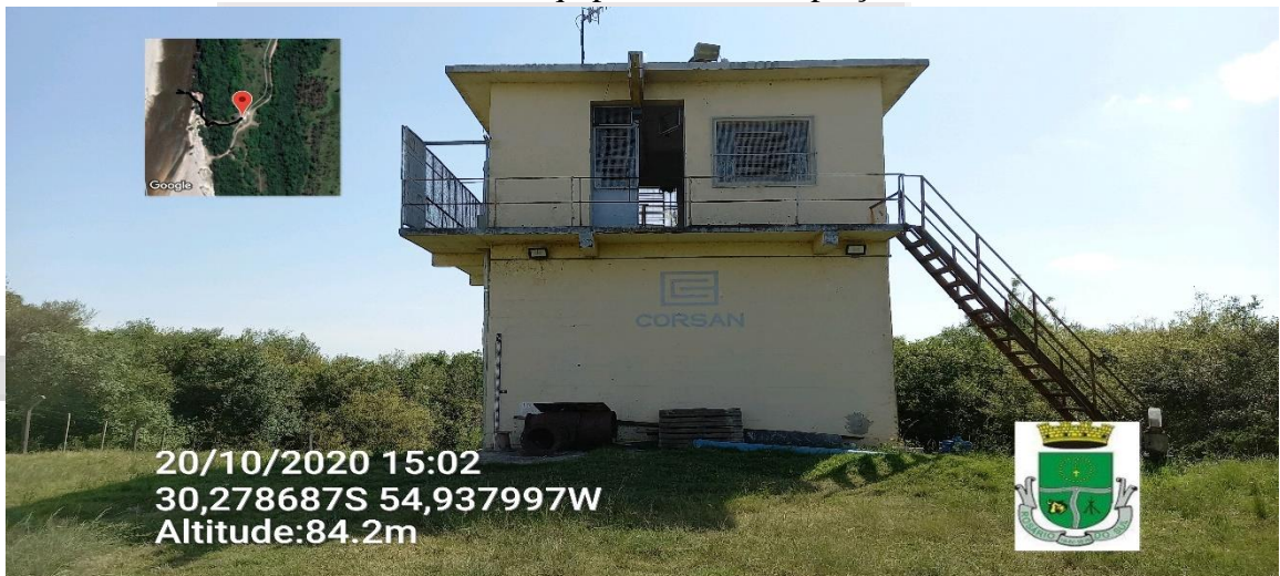
Foto 5: Local de monitoramento dos equipamentos de captação
