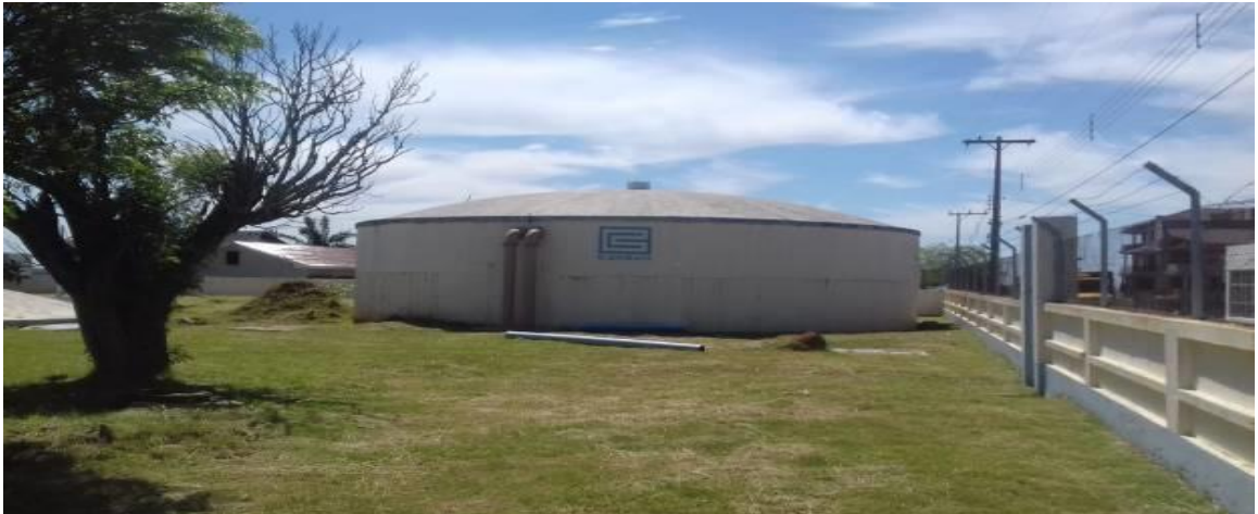
Foto 16: Reservatório Rua Júlio de Castilhos
