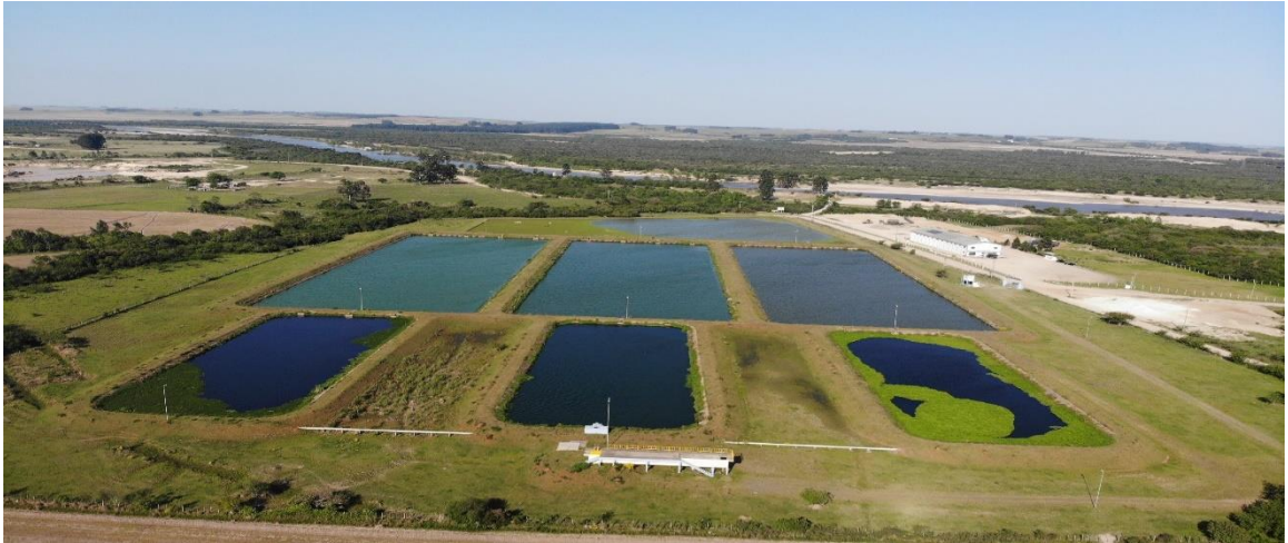
Foto 25: EBE 03 – Recebimento de Esgotos - Bairro Vila Nova
