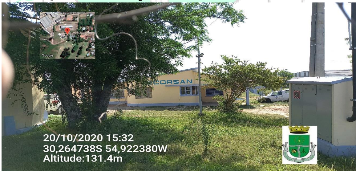
Foto 6: Estação de tratamento de água
