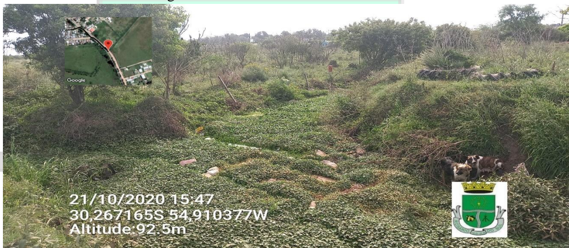
Foto 56: Sistema de drenagem - Avenida Flores da Cunha
