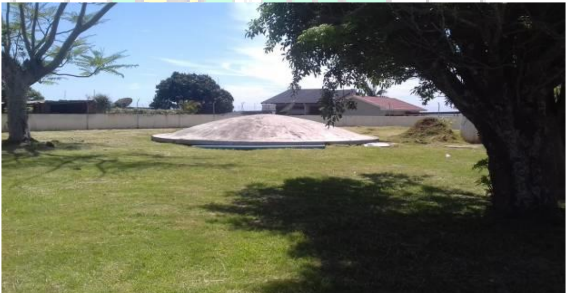
Foto 15: Reservatório Rua Júlio de Castilhos
