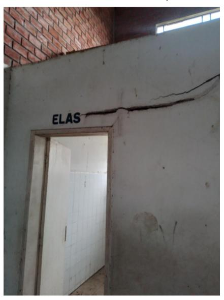
D- Rachaduras deverão ser sanadas com chaves a cada 50 cm e rebocos refeitos sem a necessidade de refazer as paredes, lateral das arquibancadas.
