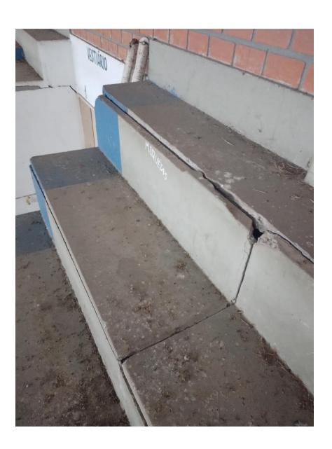
J- fechamento das fendas horizontais e chave de ferro nas trincas verticais e horizontal quando for na parede;
