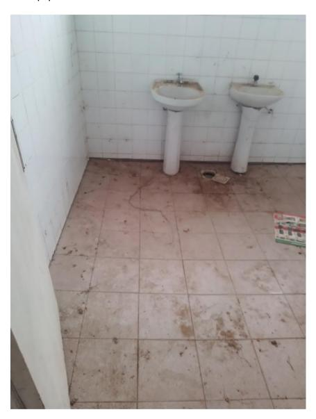
B- Equipamentos sanitários deverá ser trocado por vaso com caixa acoplada da cor branca apos reforma do contrapiso, revestimentos de parede e piso.
