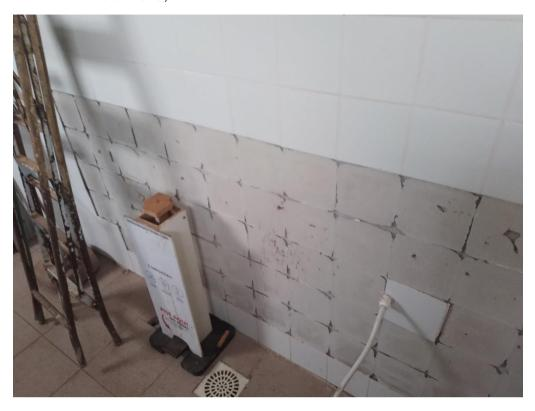
Q- revestimentos nas paredes devem ser retirados e colocados novos com cimentocola AC-3;
