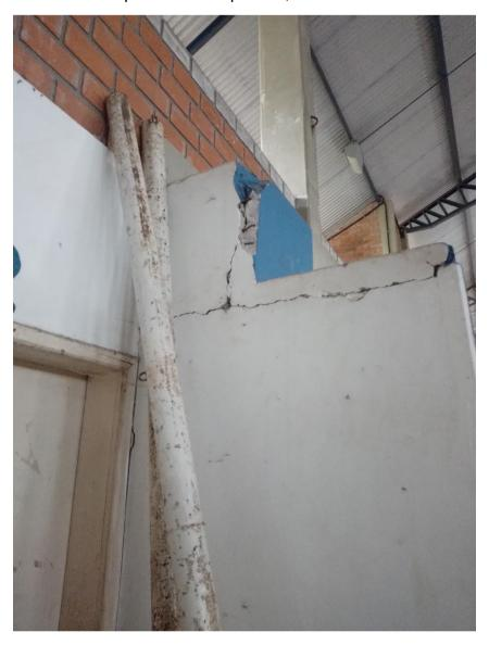
K- apos o conserto das rachaduras, instalação de perfis, e refazer o reboco nas partes afetadas por trincas, as arquibancadas devem ser pintadas;
