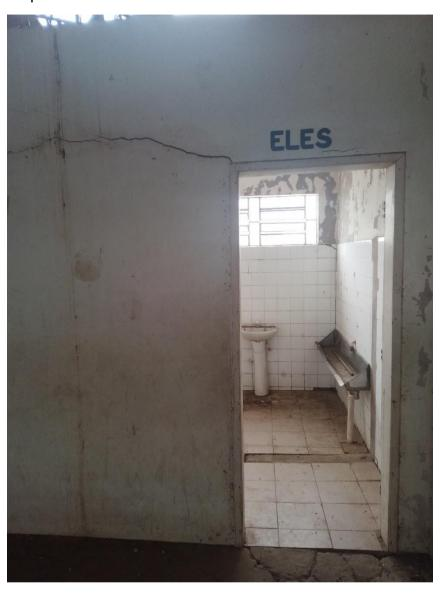
F- revestimento do piso e das paredes sendo necessária a sua subtituição;
