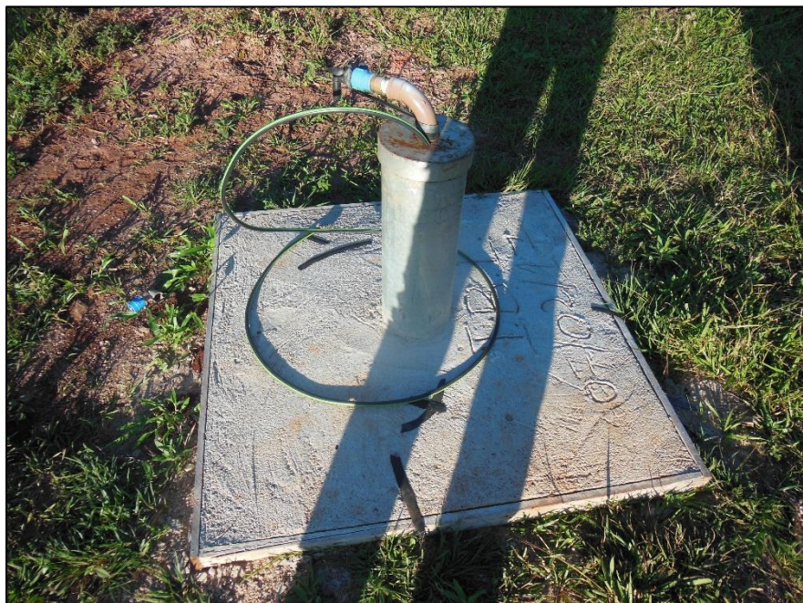
Foto 02 :Laje de proteção.
